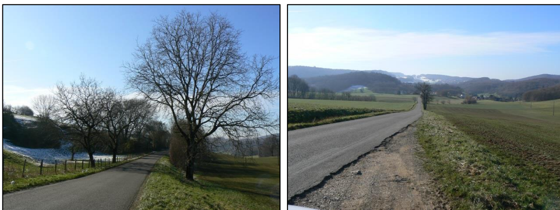
RD 478, en sortie de Larnod-gare accompagnée d'arbres d'alignement avant de présenter un paysage ouvert sur le relief de la vallée du Doubs.
