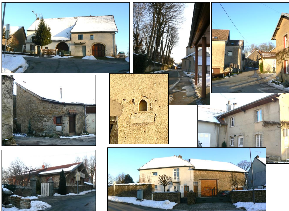
Illustrations du bâti du centre ancien – alignement sur rue, détails architecturaux et murs en pierres.
