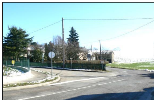
Problème de hiérarchisation et de sécurité au niveau de la jonction entre la rue de la Gare et la voie Royale.
