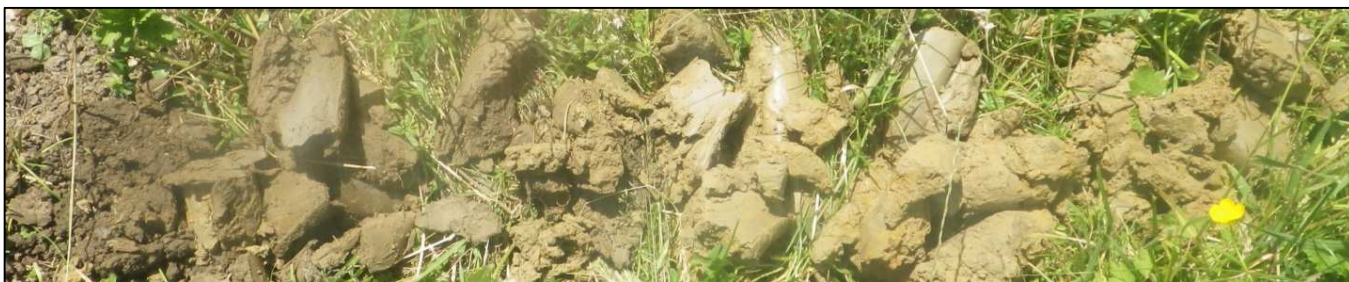
Sol argileux sur marnes grises au milieu de talus sur la parcelle 29.
