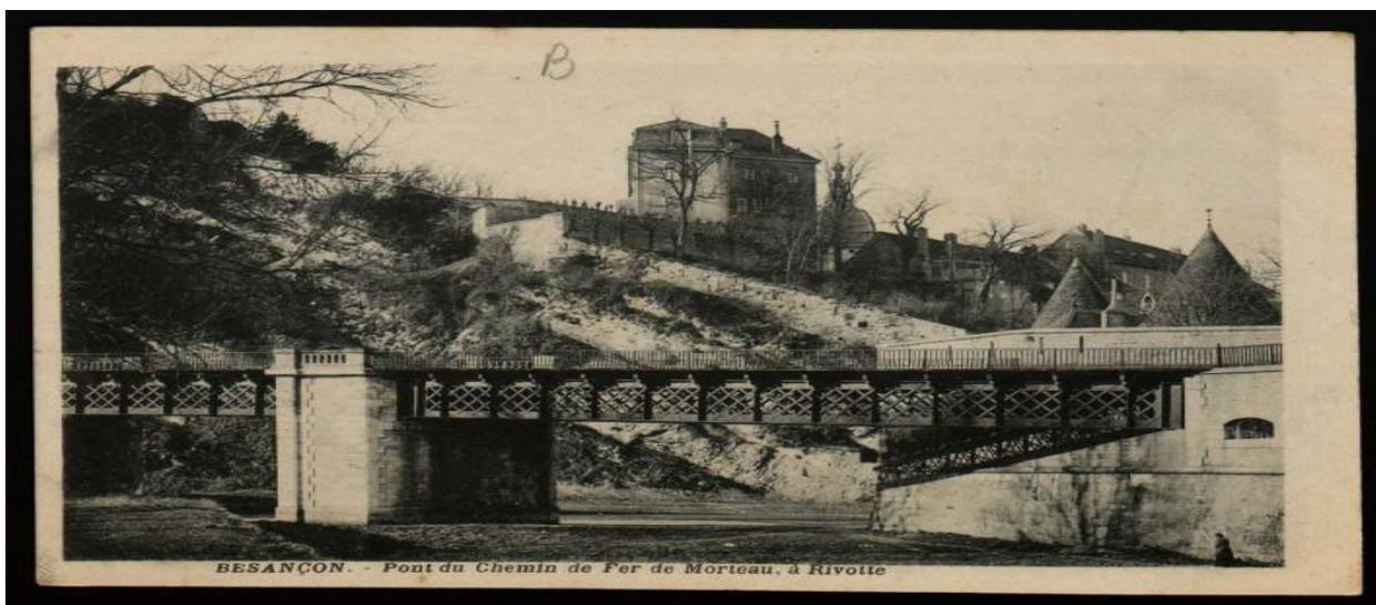
Ce pont métallique à une voie fut construit en 1884 à la sortie de la gare de la mouillère, afin de faire franchir le Doubs à la ligne Besançon – Le Locle via Morteau. Il repose sur deux piles, puis se prolonge entre la Tour et la porte Rivotte afin de rejoindre la falaise en bas de la Citadelle. Plastiqué durant la Seconde Guerre Mondiale, il est toujours en service.
