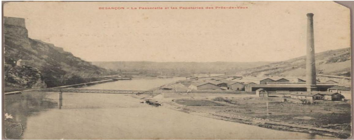
Datant de 1898, la passerelle piétonne, permettait un accès aux ouvriers un accès de la papèterie et de la fabrique de soie artificielle implantées au Prés de Vaux. Cette usine fut créée par HILAIRE de CHARDONNET en 1884. Elle comporte deux éléments : un pilier central, deux culées d'origine et un tablier en béton précontraint de première génération, datant de 1948.
